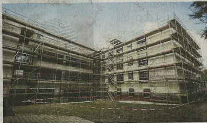
Der Rohbau des Georg-Schriever-Hauses steht, Mitte 2025 soll das Gebäude bezugsfertig sein.
